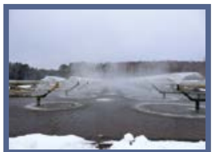
Насосная станция II-го подъёма (Площадка 2)
