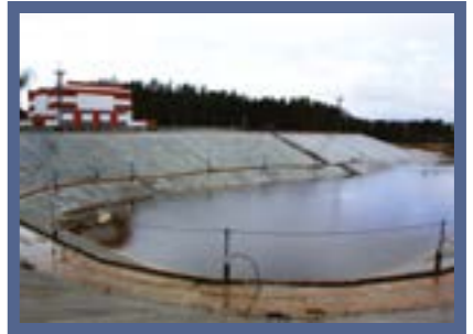
Насосная станция I-го подъёма (Площадка 1)
