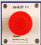
Кнопка предназначена для проверки работоспособности клапана дымоудаления. Нажав кнопку клапан откроется, нажав повторно клапан вернётся в исходное состояние. Нажатие не приводит к включению каких-либо иных систем.
